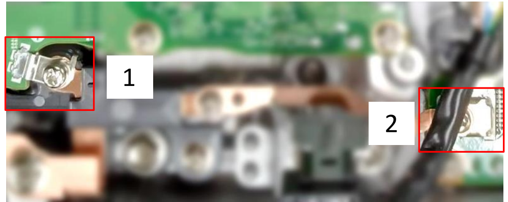
基板間接続全体
